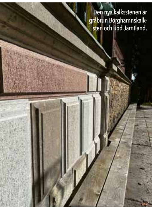
Muren från insidan. Kalkstenspartiet övergår till sandsten i murens förlängning.
