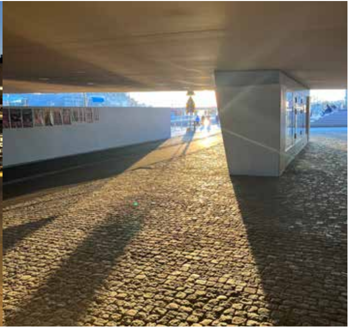
Under Guldbron ligger återbrukad gatsten från Norra Hammarbyhamnen.
