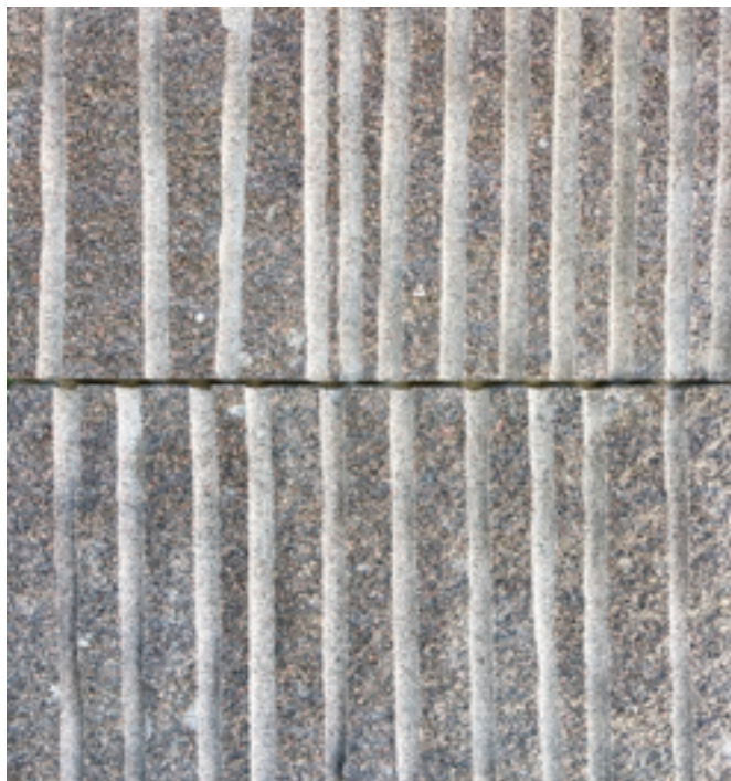
▲ Sockeln är uppbyggd med en modern form av sågbakar i Skarstad Röd Bohus.
