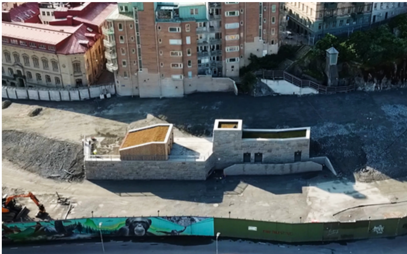
Kvarnbergets servicebyggnad har en råkilad granitfasad, cirka 300 kvadratmeter med Tossene Grå Bohus och Skarstad Röd Bohus. Stensorterna återkommer i markhällar, gatsten, blocksteg och mindre fasadytor.
